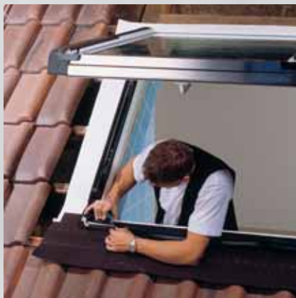
Замена производится изнутри.
